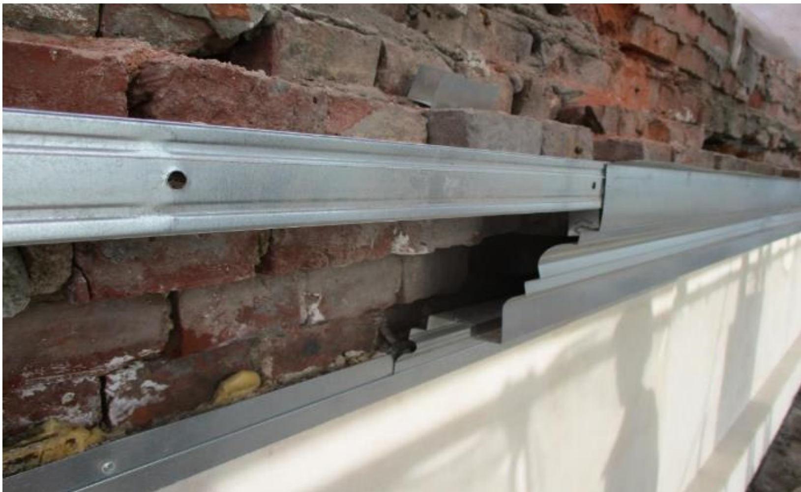
Илл. 14. Установка профилированного металлического карниза по металлическому профилю
