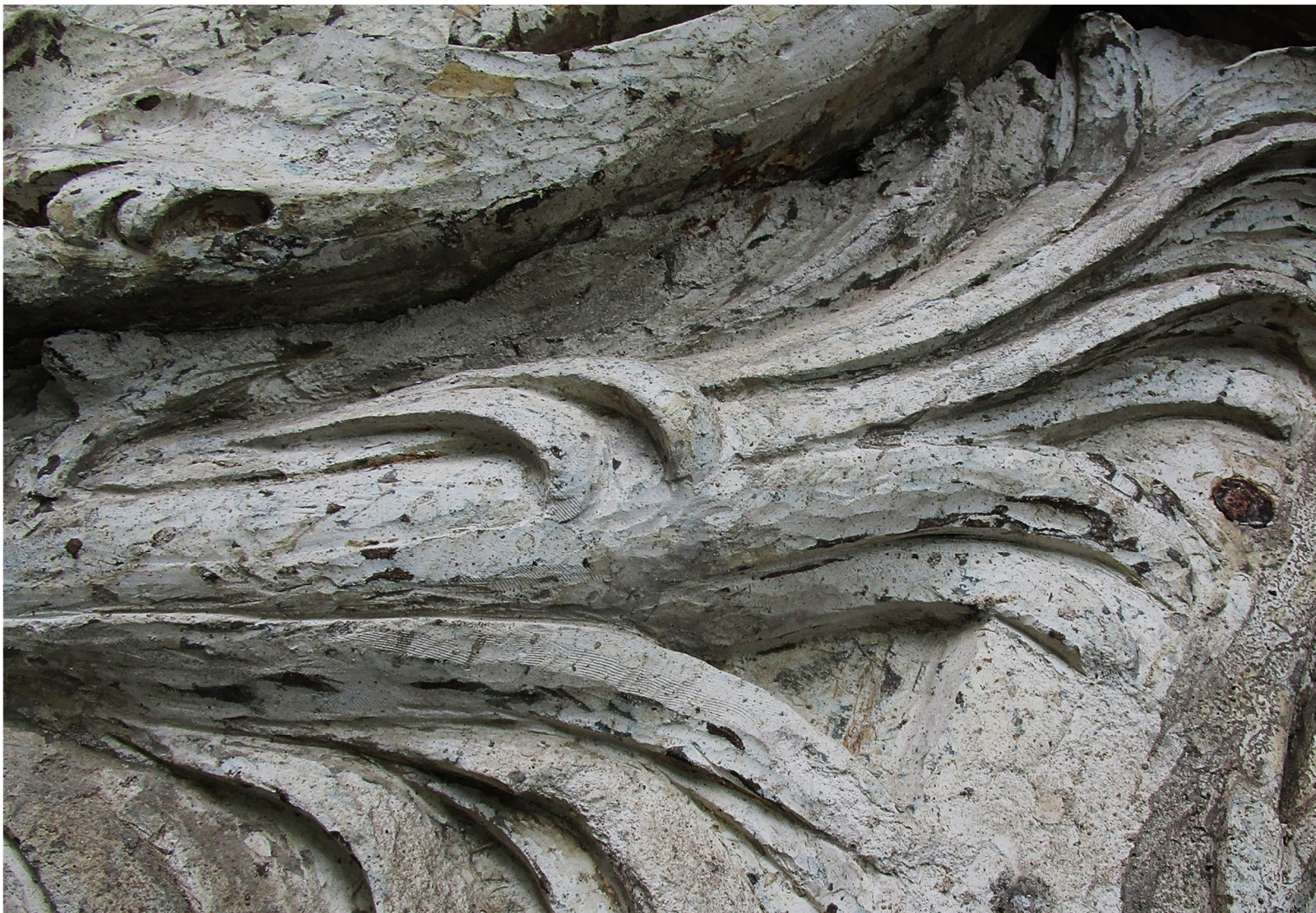
Илл. 10 Расчистка лепного декора должна производиться смывками для удаления старой краски. Стесывание поверхности жестким металлическим инструментом запрещено!
