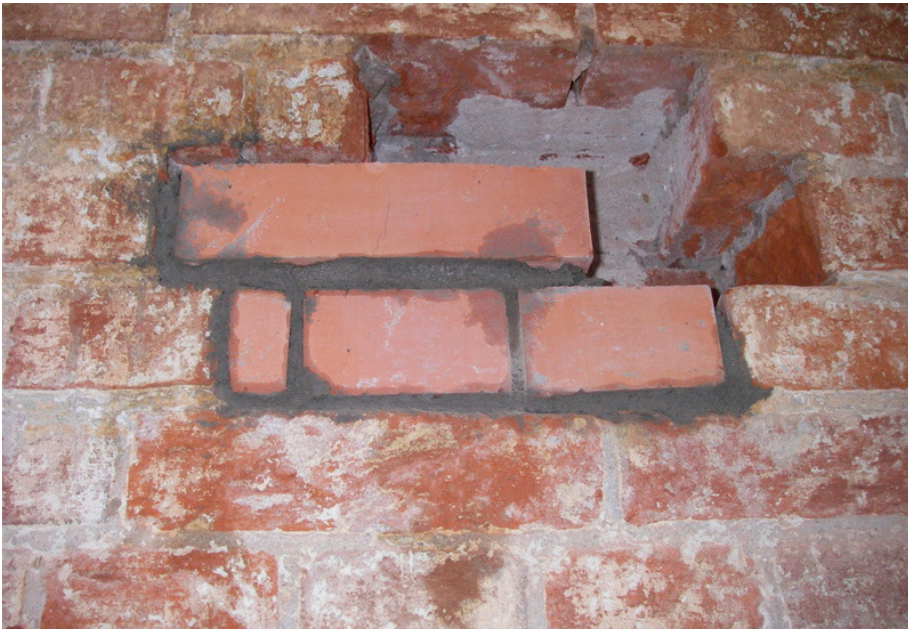
Илл. 1 Вычинка кирпичной кладки с установкой нового кирпича на сложный кладочный раствор
