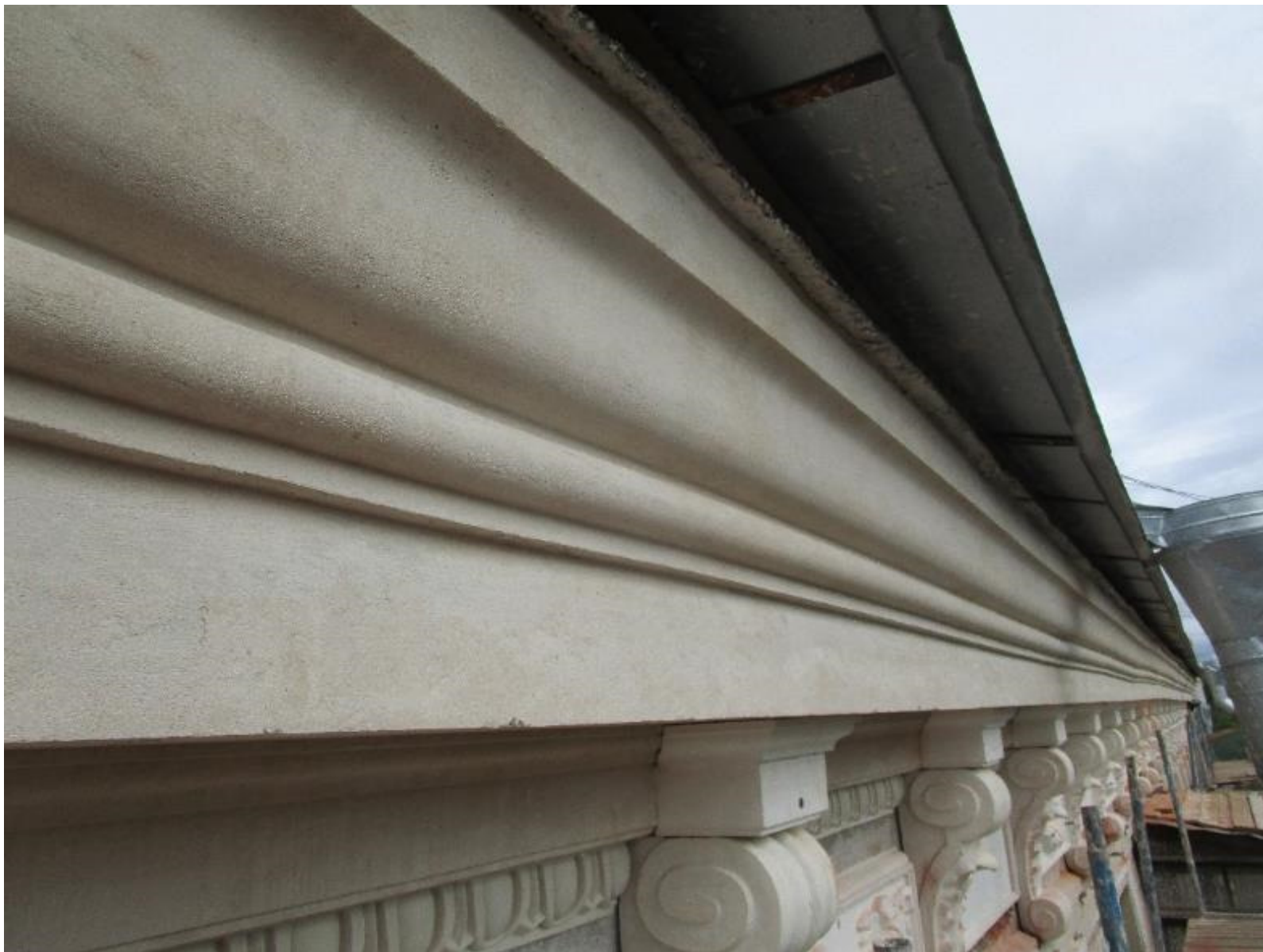
Илл. 9 Протягивание профилированных тяг по шаблонам в финишной (накрывочной) штукатурке
