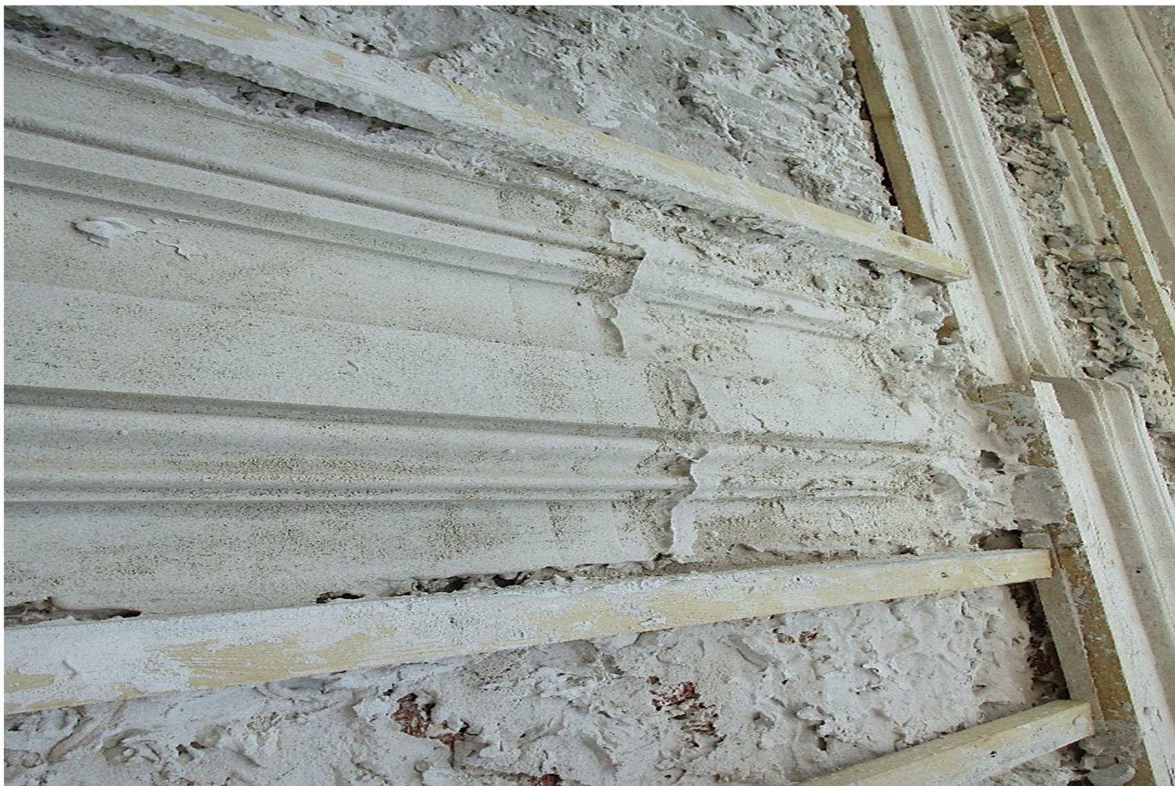
Илл. 8 Протягивание профилированных тяг по шаблонам в грубозернистой штукатурке
