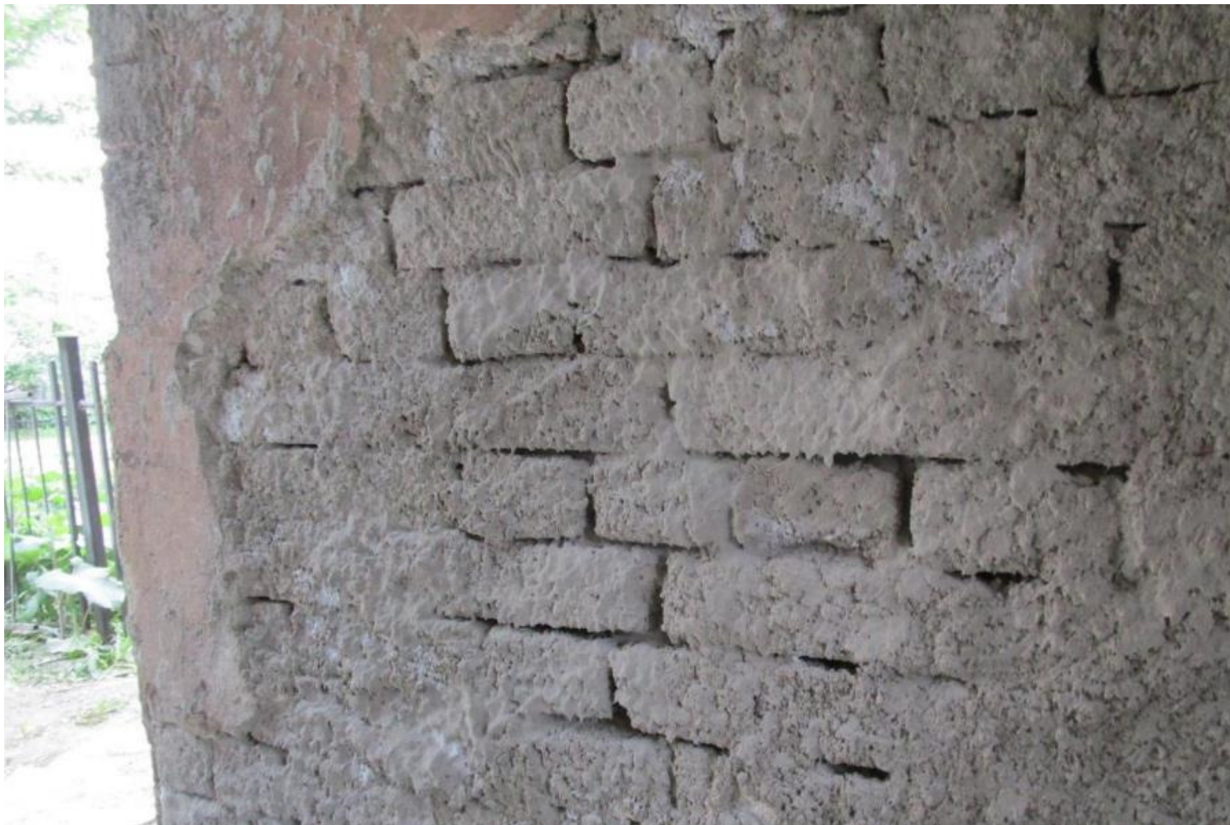
Илл. 2 Необходимость производства работ по заделке кладочных швов до нанесения обрызга обусловлена недопустимостью формирования воздушных полостей между кладкой и штукатуркой
