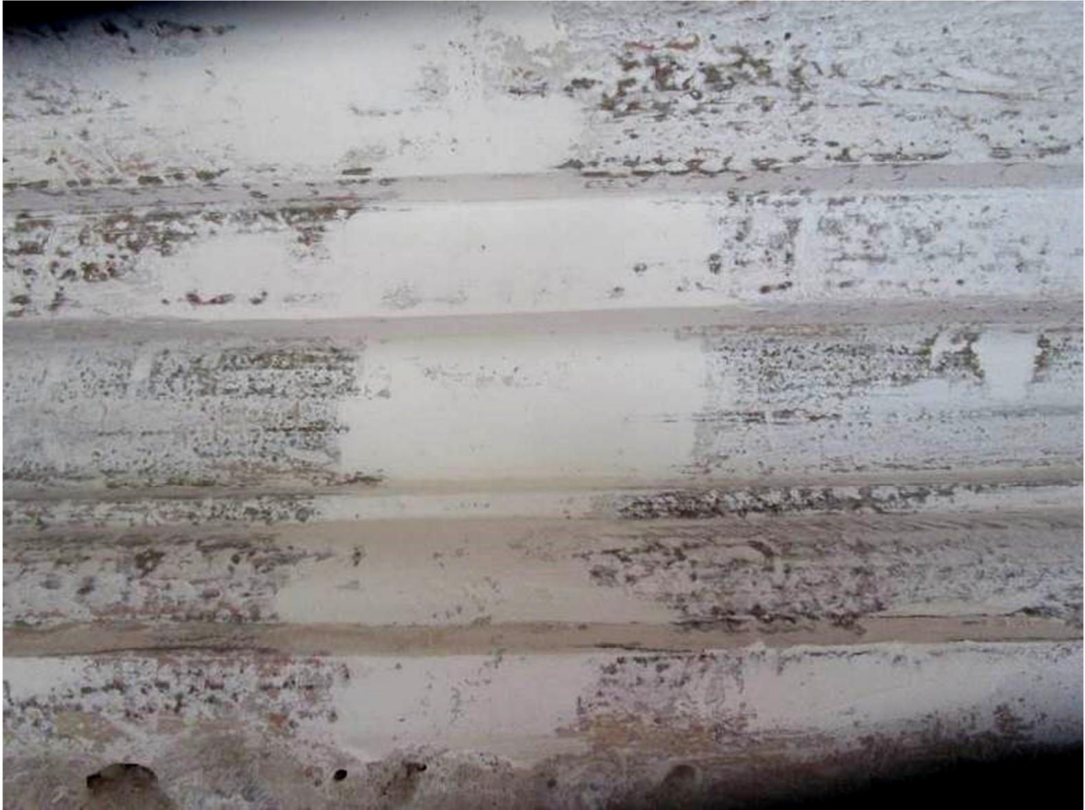
Илл. 7 Заделка мелких дефектов профилированного элемента и локальное сглаживание новых и сохраняемых фрагментов тяги мелкозернистой шпатлевкой с зачисткой до состояния на сдир
