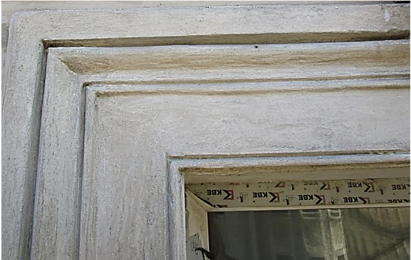
Илл. 6 «Сухая» расчистка профилированного элемента шлифовальным полотном, стамеской и надфилями (в углублениях)
