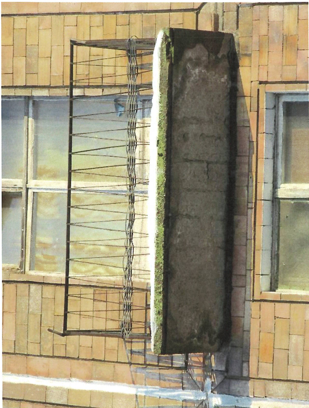
Типовая панель с ковровой облицовкой без межплиточных швов и заземленной бетонной балконной плитой
