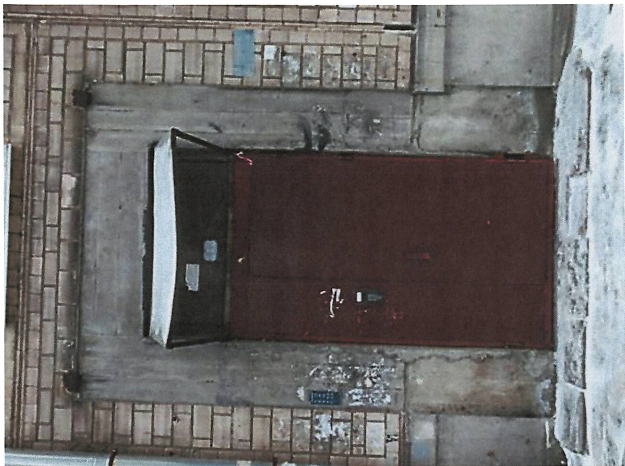
Портал входной группы и цоколь в оригинальной камневидной отделке
