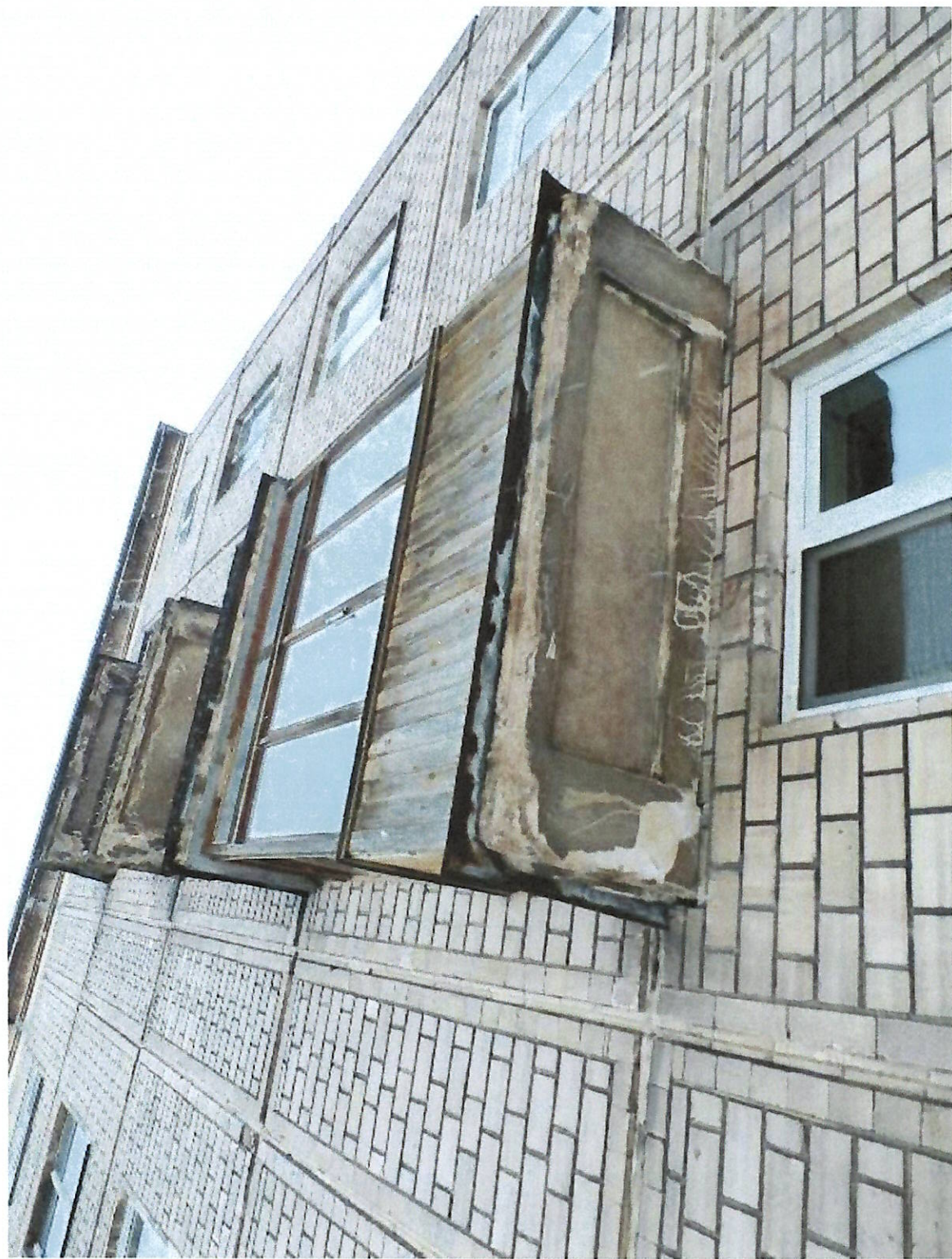
Типовая панель с межплиточными швами и штукатурной отделкой балкона
