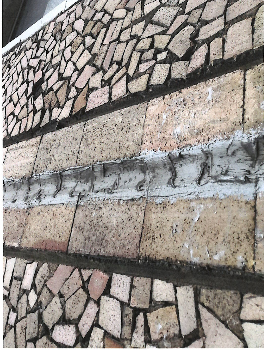
Выветренные швы мозаичной облицовки и локальные участки утрат подлежат заделке
