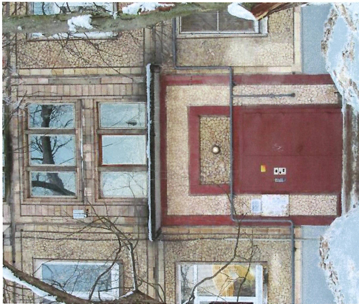
Портал входной группы в глазурованной ковровой и мозаичной плитке
