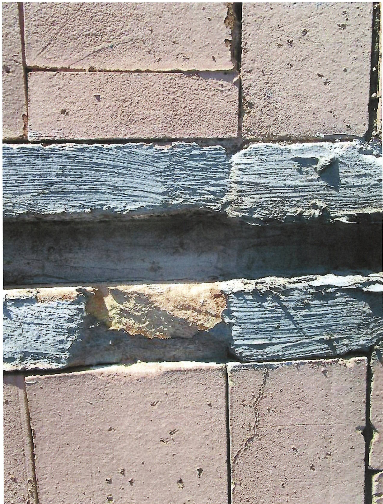
Запаренная под мастикой поверхность обрамляющего панель керамического элемента
