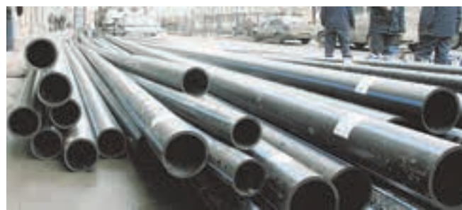
В 2016 г. краткосрочный план капремонта сформирован на общую сумму 8,94 млрд рублей. Предполагается, что на эти деньги будут проведены 13 видов работ. ФОТО: BALTRPHOTO / А. ФЕДОРОВ
